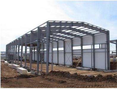
Изготовление и Монтаж здания технопарка 18x78 м (h=10,5 м) г. Вятские Поляны, 246 тн
